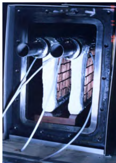
Рис. 6. Термоелектричний рекуператор, що встановлено на тепловій електростанції компанії Tokyo Electric Power Company [106].
