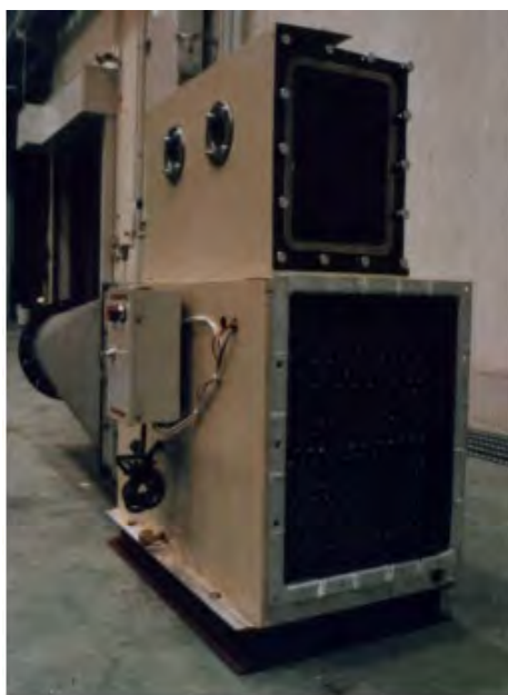
Рис. 6. Термоелектричний рекуператор, що встановлено на тепловій електростанції компанії Tokyo Electric Power Company [106].
